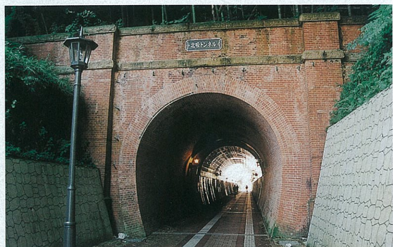
明治37年、軍港引込線として設けられた、れんがづくりのトンネル。
