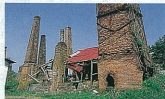
神崎ホフマン窯 れんが製造のために建造された窯。連続焼成が可能なホフマン窯は、現在日本で4基しか残っていない貴重な産業遺産で、国の登録有形文化財にも登録されています。
