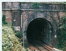
清道トンネル
