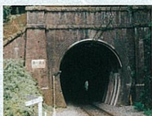
第一真倉トンネル
