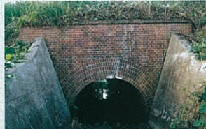
橋梁(円満寺、アーチ)
