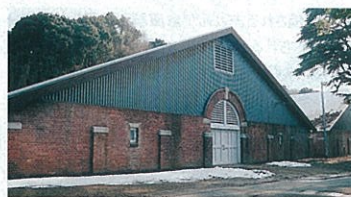
旧北吸浄水場配水池 明治34年から大正期にかけて旧海軍の水道施設が建設されてきました。アーチ状にれんがが積み重ねられているなど、意匠的にも貴重で、国の重要文化財に指定されています。現在は倉庫として活用しています。
