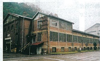
ユニバーサル造船 かつては海軍工廠として駆逐艦などを建造していました。工場の敷地内には、数多くの近代化遺産が残っており、いずれも工場や倉庫等として現役で使用されています。
